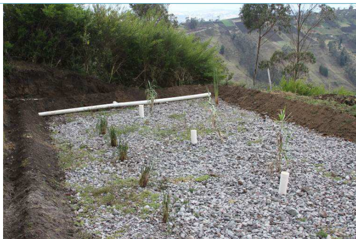
El bio-filtro funciona en un area de 11x7 metros
