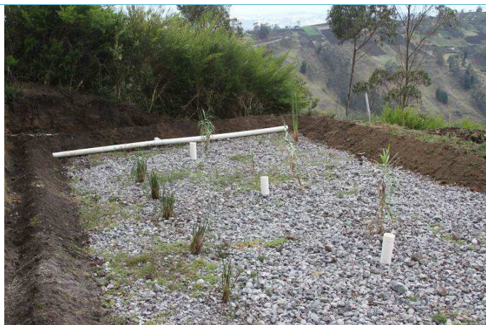
Bio-Filter auf einer Fläche von 11x7 Metern
