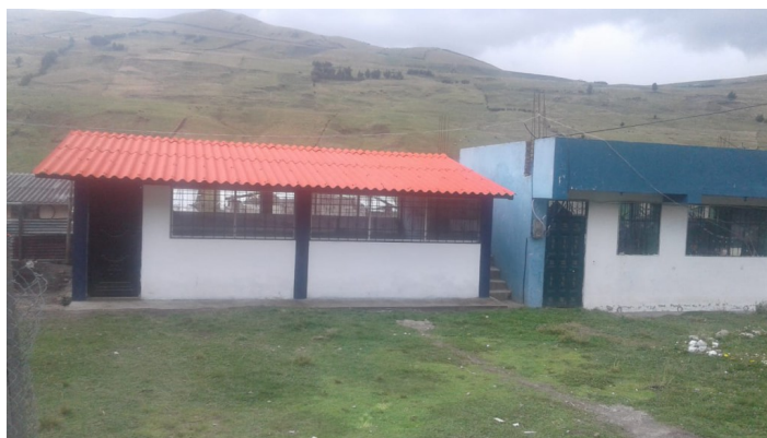
El aula de Atillo termina. Se trata de una construcción de ladrillo de 50 m2, con piso de madera y cielo raso.
