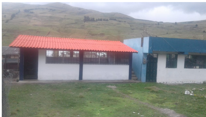
L'aula terminata. È una costruzione in mattoni di circa 50 m2, rifinita internamente con pavimento in legno e controsoffitto.
